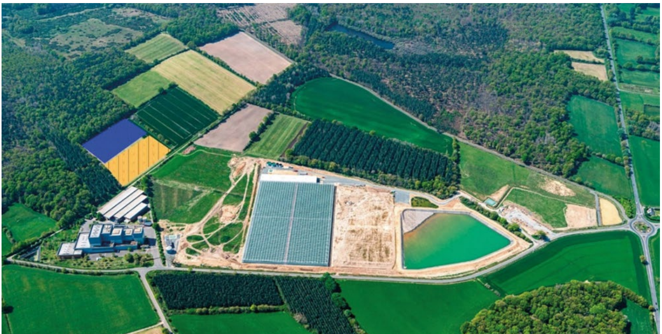
Vue générale des terrains – Projet d'extension et UVE
